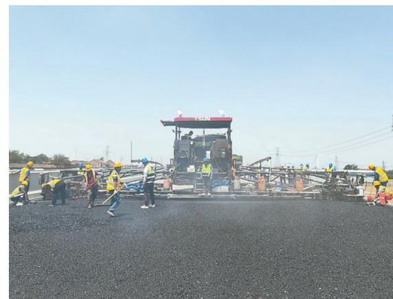
中建八局承建的沿黄高速武陟至济源段项目三标沥青路面试验段正在摊铺施工。 本报记者 朱晓琳 摄
