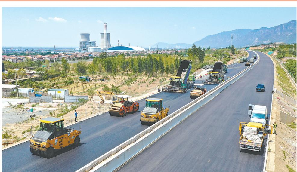
6月16日,中交一公局承建的沿太行高速焦作至济源段项目二标龙门河以西路段施工现场,20多名施工人员正在进行沥青上面层摊铺作业。 本报记者 刘金元 摄
