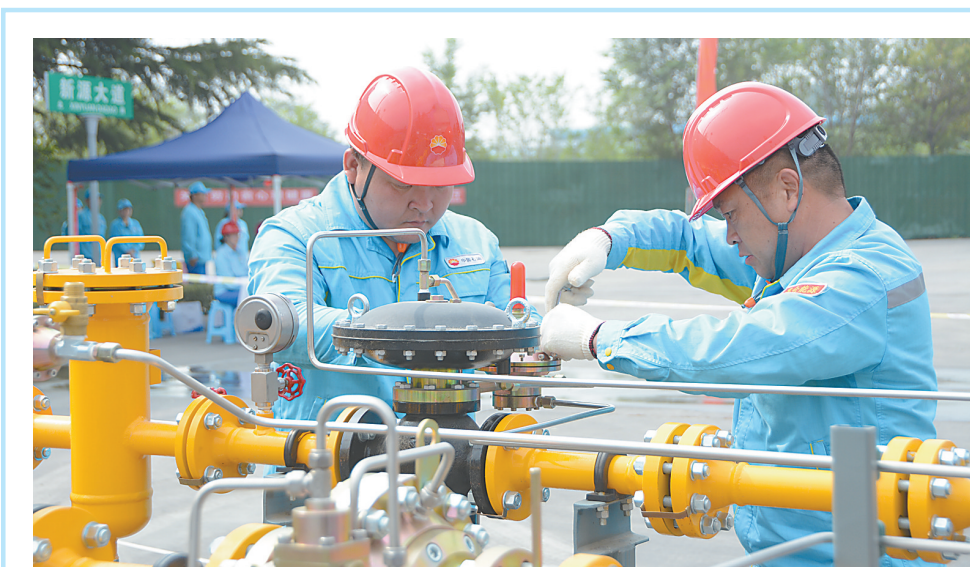
6月20日，博爱县开展2025年用户端天然气泄漏应急演练，进一步提高应对紧急情况和突发事件处置的能力，完善应急管理体系，切实保障用户端用气安全。此次演练，严格遵循“平战结合、实战导向”的原则，采用“情景构建+实战推演”的模式，完整模拟从预警响应、应急处置到恢复重建的全过程，突出全面、真实、高效的特点。樊兴盛 摄
