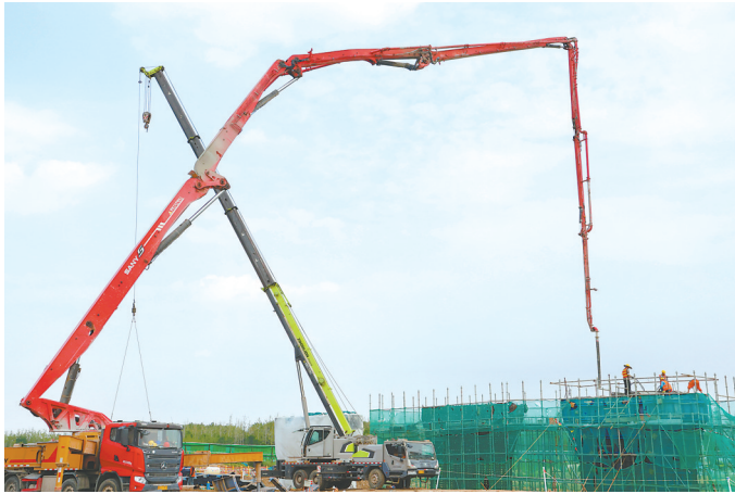
6月29日，山阳路（南海路—黄河大道）建设项目大沙河桥施工现场，建筑工人在有序作业。该项目总投资2.12亿元，其中大沙河桥投资1.58亿元，预计明年9月份通车。 本报记者 马雅宁 摄
