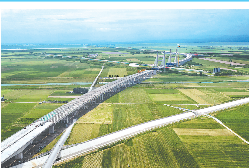
7月9日，焦平高速焦荣段项目三标施工现场，河南省公路局焦平高速焦荣段总承包部第三经理部的建设者加班加点，全力推进项目建设。
