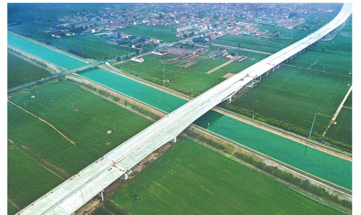
7月26日,鸟瞰沿黄高速武陟至济源段项目三标南水北调特大桥。南水北调特大桥是沿黄高速武陟至济源段项目三大重点控制性工程之一,桥梁全长1128米,共8联,采用变截面预应力混凝土连续箱梁。经过中建八局建设者保质量、保工期不间断施工,目前桥面施工已完成。 本报记者 刘金元 摄
