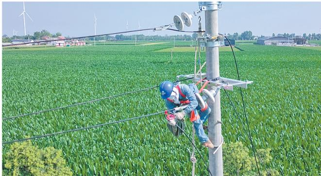
7月30日上午，在温县番田镇西南马村北的玉米地旁，国网温县供电公司施工人员战高温、斗酷暑，集中开展10千伏城外线西南马9号台区支线架设工作，旨在解决原西南马4号台区重载问题，确保度夏期间该区域电网稳定运行，群众用电可靠。
