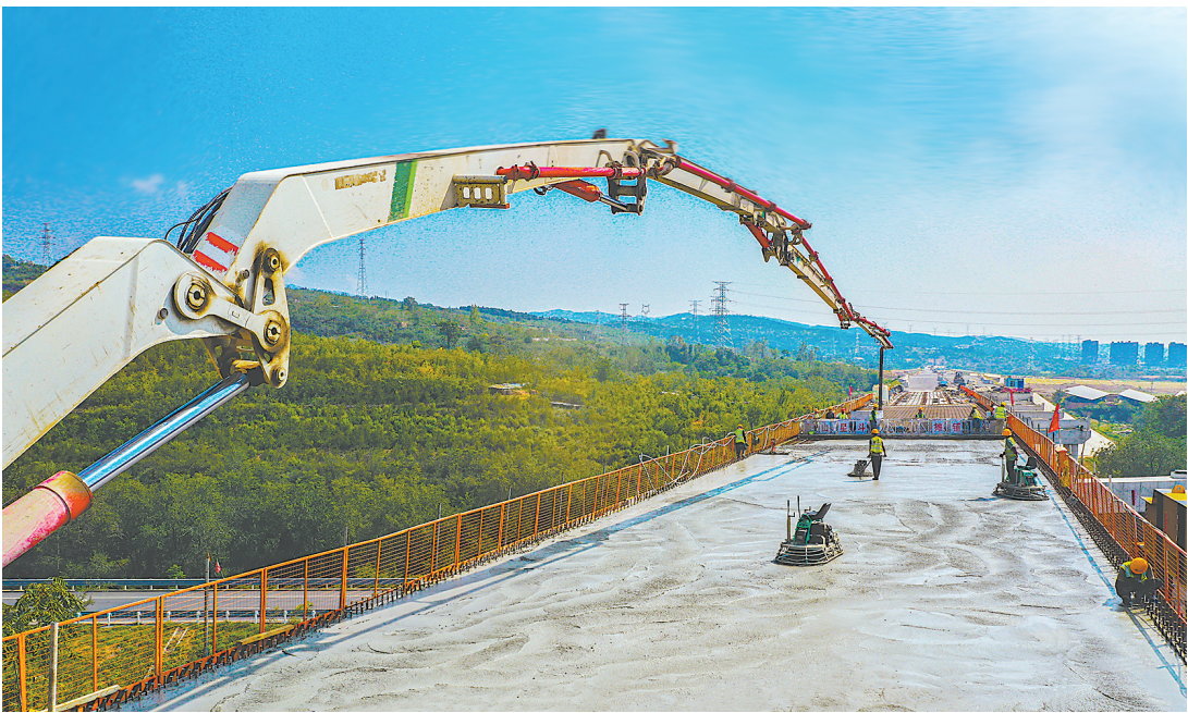
8月2日，沿太行高速焦作至济源段一标跨晋新高速分离式立交桥施工现场，河南省公路工程局的建设者在进行桥面系浇筑，加快推进施工进度。 本报记者 刘金元 摄
