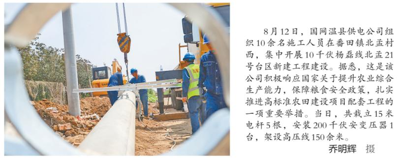
8月12日,国网温县供电公司组织10余名施工人员在番田镇北孟村西,集中开展10千伏杨磊线北孟21号台区新建工程建设。据悉,这是该公司积极响应国家关于提升农业综合生产能力,保障粮食安全政策,扎实推进高标准农田建设项目配套工程的一项重要举措。当日,共栽立15米电杆5根,安装200千伏变压器1台,架设高压线150余米。乔明辉 摄
