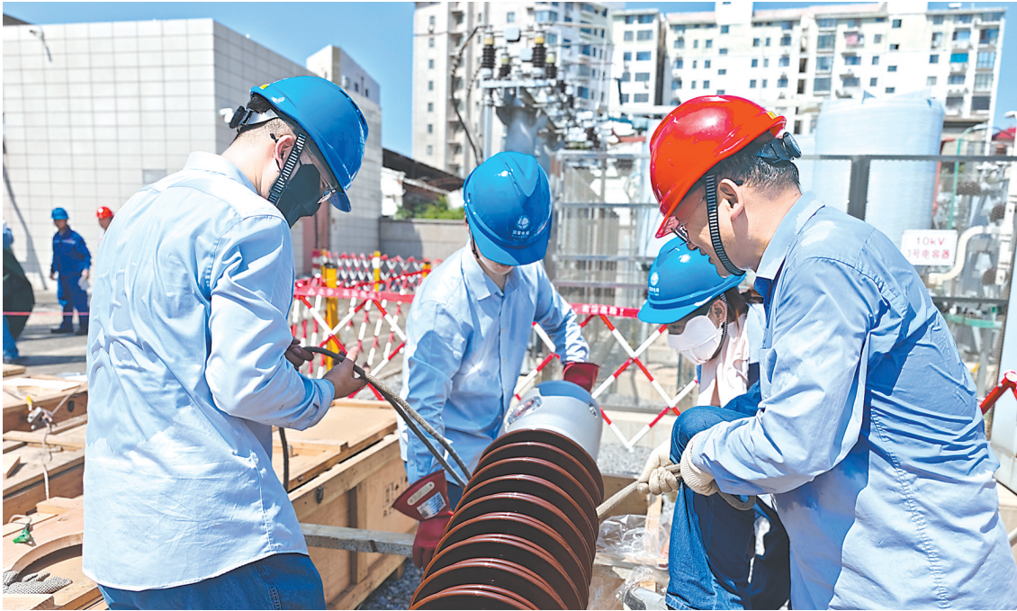
更换电器设备。
