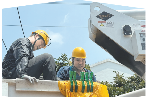
实施不停电作业。
