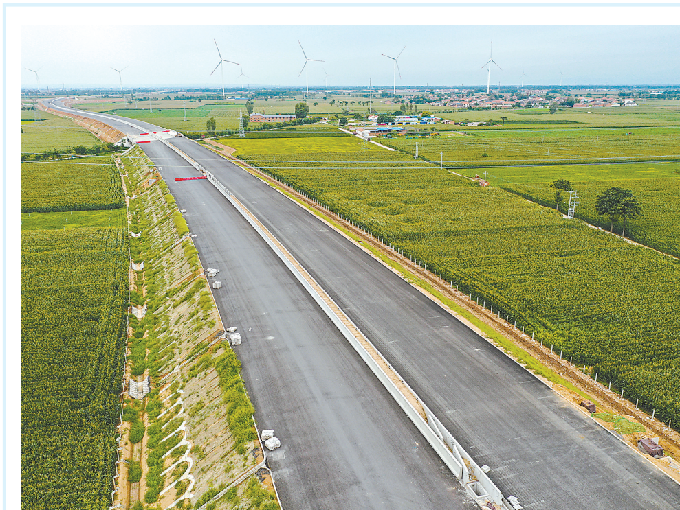
8月26日,中建八局承建的沿黄高速武陟至济源段项目三标水稳层摊铺工作已全面完成,在黄河北岸的山阳大地,一条新铺设的大道蜿蜒盘踞,雏形已现。本报记者 刘金元 摄
