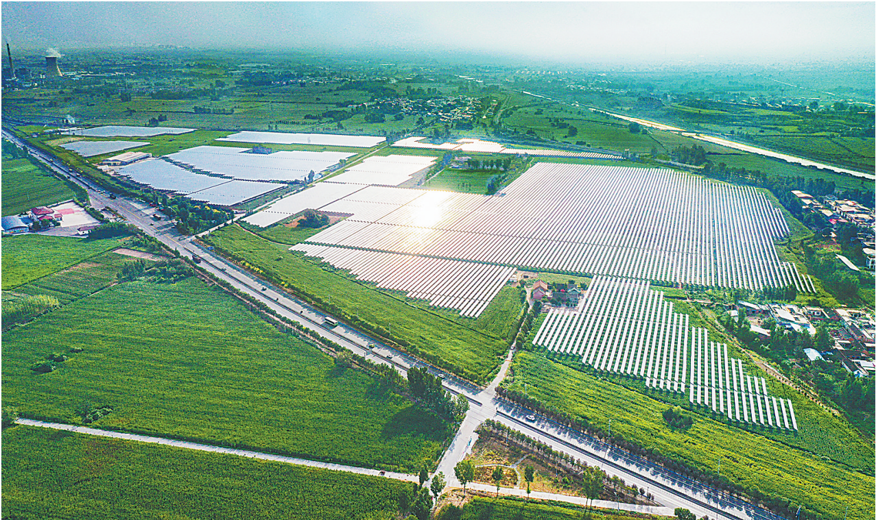
8月29日，在马村区安阳城街道山后村拍摄的光伏电站场景。目前，这里建有焦作中晖50兆瓦光伏电站项目和河南中科田园农业科技有限公司农光互补项目，上部光伏发电，下部种植蔬菜、中草药等，发电种植两不误，为当地经济可持续发展注入了新动能。
