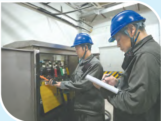
(本栏照片均为“一赛一节”开幕式保电现场)
