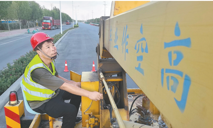
9月21日，高新区城管中心市政人员在维修路灯设施。 本报记者 高小豹 摄
