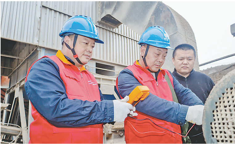
10月10日，国网温县供电公司组织焦裕禄共产党员服务队走进温县悦鑫农业有限公司开展走访服务，结合近期多雨实际，重点对企业的遴选、烘干、传送等设备进行全面排查，全力保障秋收期间该类企业设备和线路健康运行，以“满格电”护航秋粮颗粒归仓。乔明辉 摄
