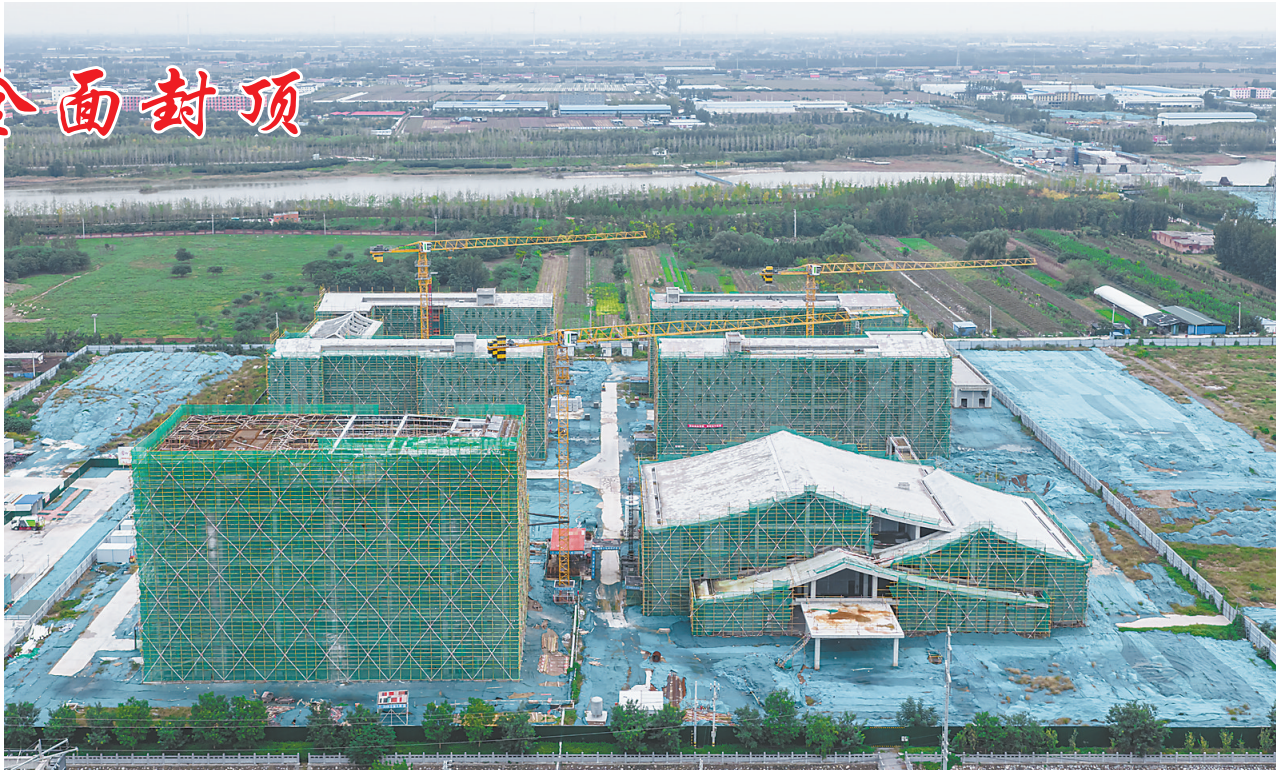
10月22日，位于高新区的焦作市养老综合服务中心项目2号楼顺利封顶。
