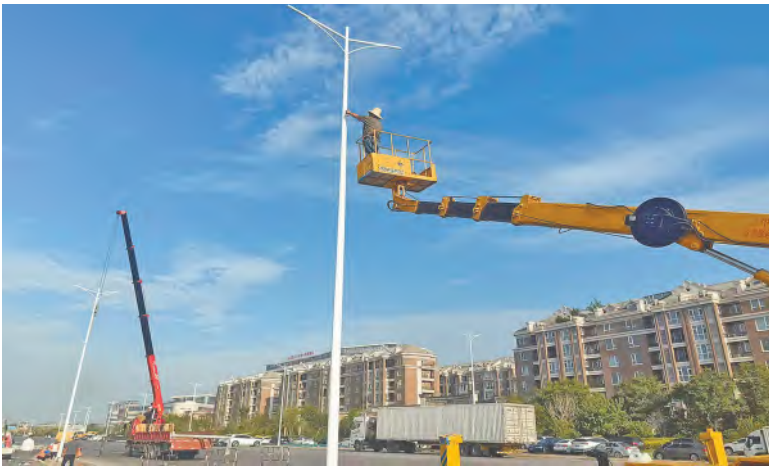
世纪路东延安装路灯。
