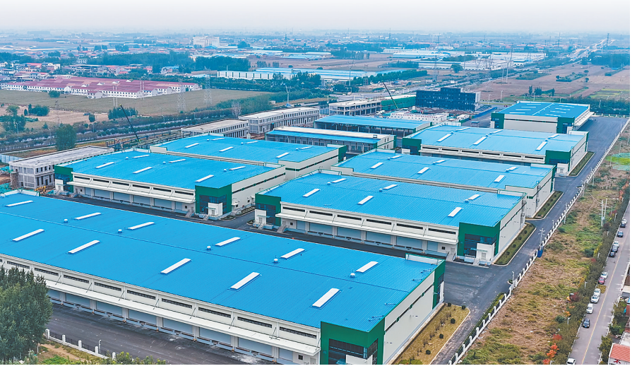
10月22日，低碳数智物流枢纽基地项目现场，工人们在加紧建设综合服务办公楼。
