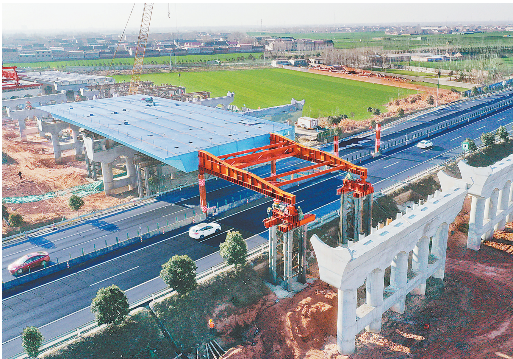
2021年12月30日,市东海大道跨荷宝高速桥钢箱梁顶推施工正在进行中。市东海大道项目跨荷宝高速桥采用单跨60米等截面钢箱梁,单幅桥梁总宽26米,梁高2.8米,单幅重量1080.45吨。
