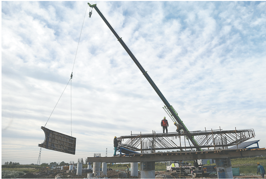
10月9日,施工人员进行我市大沙河解放区河段(幸福桥)工程桥体盖梁施工。据了解,该项目不仅是缓解解放区大沙河灵泉坡村、小北张村、郭村等4个行政村群众车辆出行难的民生项目,更是我市大沙河防洪治理的重点建设项目。 李良贵 摄
