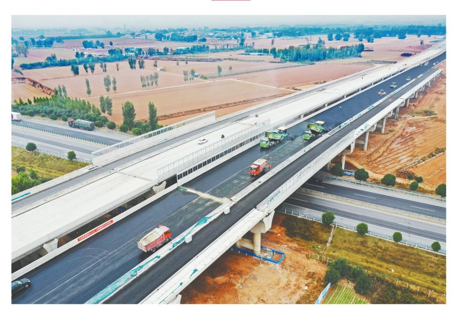
11月8日,市东海大道建设项目跨菏宝高速桥正在铺设沥青路面。该项目在市投资集团有限公司的积极组织下,工程进展顺利。目前,东海大道大沙河以北已建成完工,大沙河以南路段道路主体
