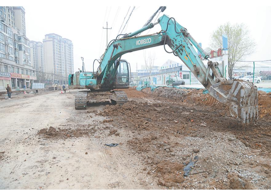
3月20日,解放区组织施工力量平整林园路路基。林园路改造工程全长1.3公里,主车道宽21米。为了确保林园路改造工程进度和质量,解放区组织施工人员在做好排水、排污管道施工工作的同时,加快路基的平整施工进度,预计今年6月底正式通车。
