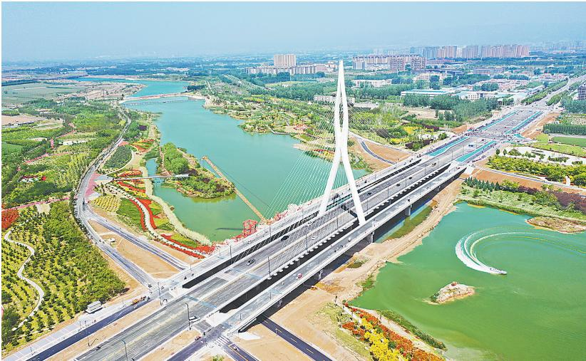
5月1日,市民主南路大沙河桥建成通车。该工程总投资1.9亿元,沿民主路向南延伸,跨过大沙河至黄河大道,长313米、宽58米,设计使用年限100年。中墩桥塔总高111.5米,是我市第一座斜拉式大桥,与大沙河生态公园景观相呼应,成为我市的地标志性建筑。
