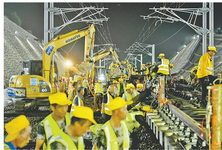
8月12日，中铁十局的工作人员在济郑高铁山东段大庙屯线路所42号道岔I级施工。8月12日晚至13日凌晨，由中铁十局承建的济（南）郑（州）高铁山东段大庙屯线路所42号道岔I级施工全部完成，标志着济郑高铁与济南铁路枢纽实现互联互通，为后续实现济郑高铁与京沪高铁、石济客专、胶济客专、济青高铁、济莱高铁互联互通奠定基础。
