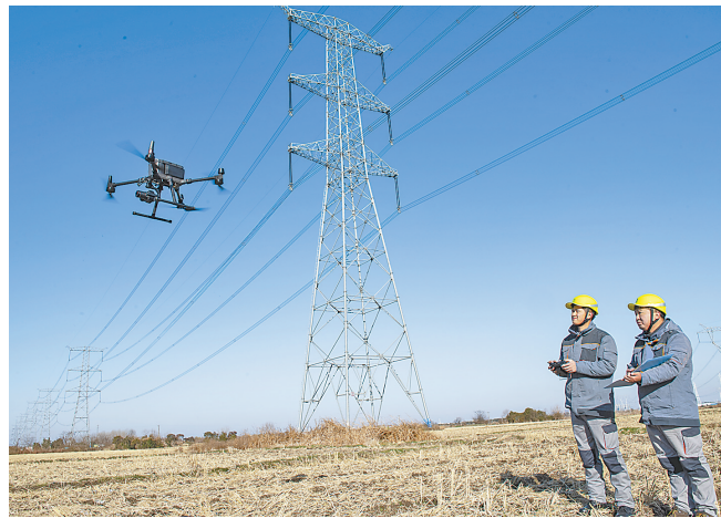
12月17日,在安徽省合肥市肥西县,安徽送变电工程有限公司检修工人在利用无人机巡检输电线路。
