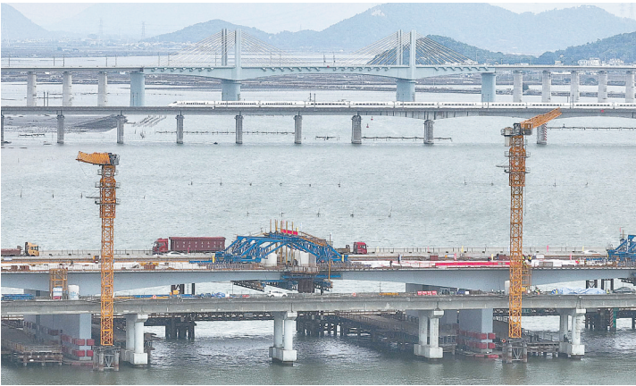
这是1月21日拍摄的深汕西高速长沙湾跨海特大桥(无人机照片)。当日,中铁四局承建的深汕西高速改扩建项目长沙湾跨海特大桥左幅主跨合龙。该项目全长约146公里,采用先新建右幅新桥,再拆除既有特大桥重建左幅的施工方案,大桥右幅已于2023年3月22日建成通车。 (新华社发)
