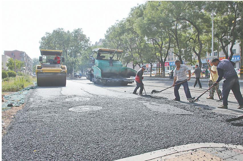
5月27日,解放区组织施工力量加大北环路道路硬化工作。解放区辖区内的太行西路和北环路是市区西北部和北部的两条主干道,不仅关乎本地群众出行的便利性,也关乎我市的整体形象。为此,解放区协调有关部门加大道路整修改造,分阶段进行施工。新整修改造的道路预计在5月底全线通车。 李良贵 摄
