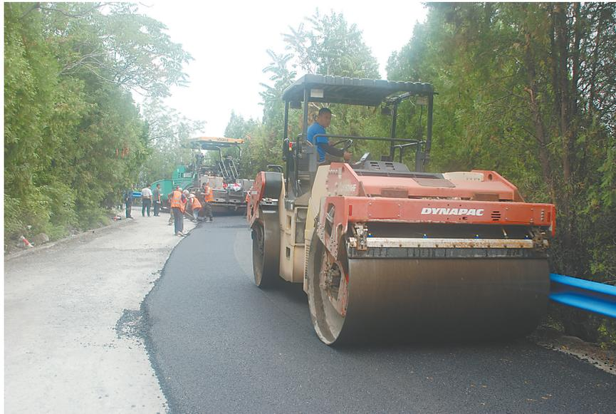
7月22日,由河南鹏程路桥建设有限公司第二分公司承建的焦作市X014北河线(麦秸河至老牛河)段提升改造工程在紧张施工中。该工程全长5.521公里,由于路面损毁严重且宽度有限,只能采取全封闭施工。目前,该工程已经进入路面铺装阶段,预计7月底完工并通车。
