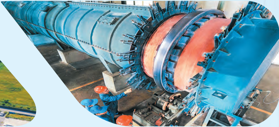
多氟多化工股份有限公司氟化铝车间。
