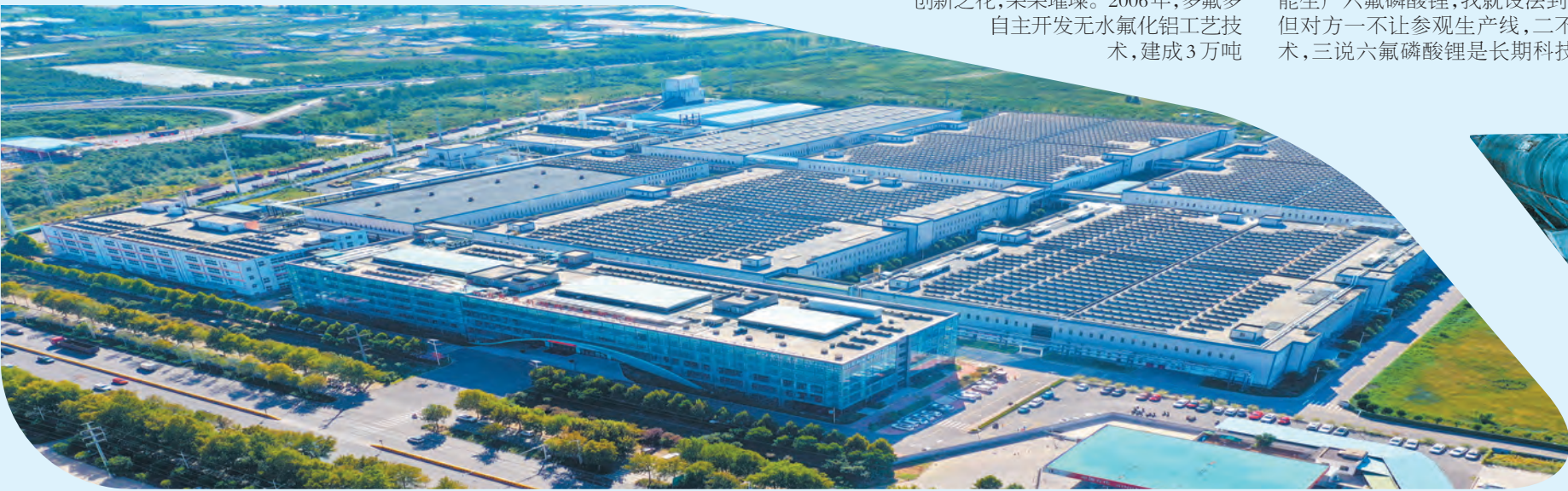
多氟多(焦作)新能源科技有限公司年产6亿瓦时能量型动力锂离子电池组项目。
