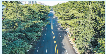
灾后重建项目建设路(焦东路-瓮涧河)恢复工程。
