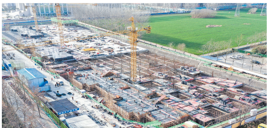
城中村改造项目稳步实施。
