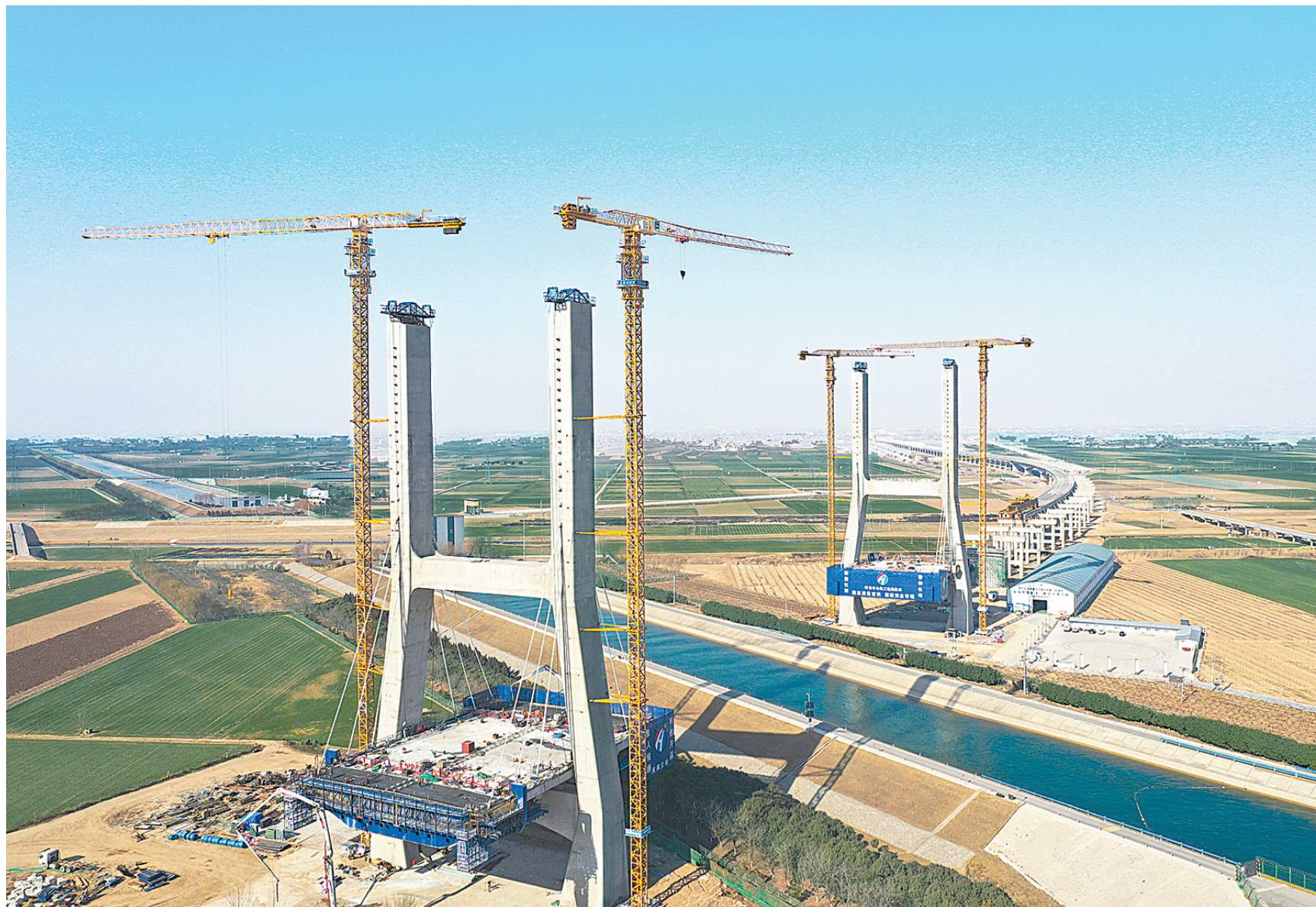
1月18日,历经10个小时的紧张施工,焦平高速焦作至荣阳段项目南水北调斜拉桥主梁3号块顺利浇筑完成。预计2025年11月份全桥合龙。本报记者 刘金元 摄
