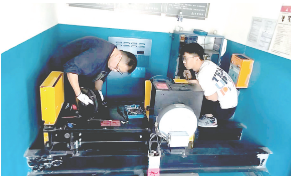
物业工 作人员在检 修电梯,为 学生提供安 心的生活环 境。 王 倩 摄
