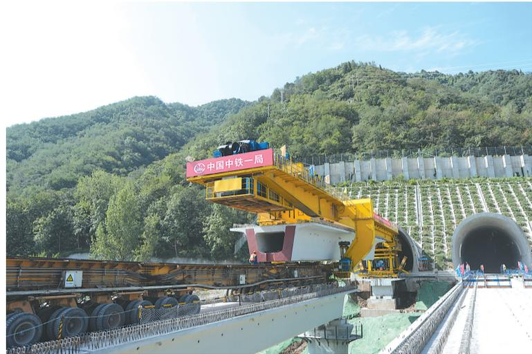
7月28日，施工人员在西康高铁跨关中环立交特大桥梁架设全线最后一孔箱梁。当日，随着架桥机将一孔长32.6米、重431.75吨的箱梁平稳落在西康高铁跨关中环立交特大桥梁墩台上，由西成客专陕西公司建设、中铁一局集团有限公司承建的西康高铁桥梁架设任务全部完成，为后续施工奠定坚实基础。穿越秦岭山脉的西康高铁，新建正线全长171公里，设计时速350公里。建成通车后将大幅缩短关中城市群与陕南秦巴山区的时空距离，方便沿线居民出行，对陕南秦巴山区乡村振兴具有重要意义。(新华社发)
