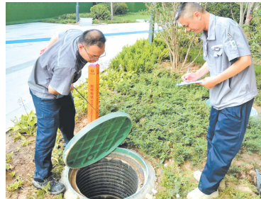
维修师傅检修园区下水设备。
