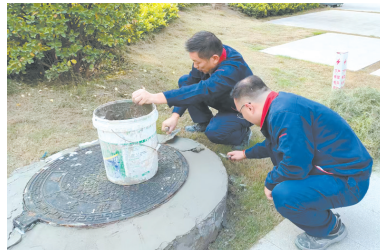
维修师傅修复破损的井盖基座。
