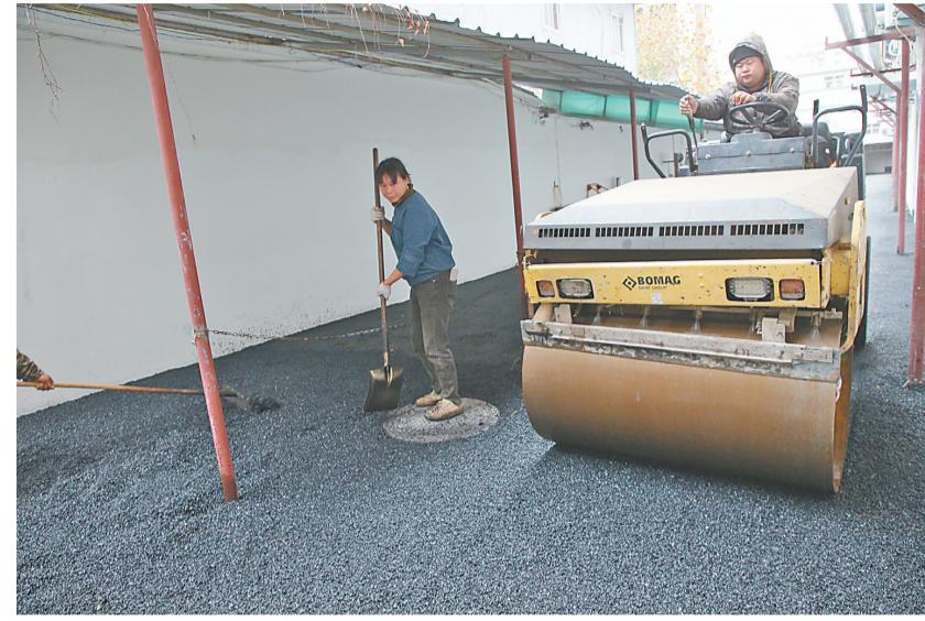
11月30日,施工人员在解放区民生街道学生路社区民主45号院内铺设沥青混凝土。进入11月以来,解放区实施辖区20个老旧楼院提质工程,重点对路灯、地面、电动车车棚、楼道消防器材等进行修整更换,目前已完成映湖路锦祥花园南门、龙源世家东门等7处破损区域的集中修复工作,维修面积约2.2万平方米。
