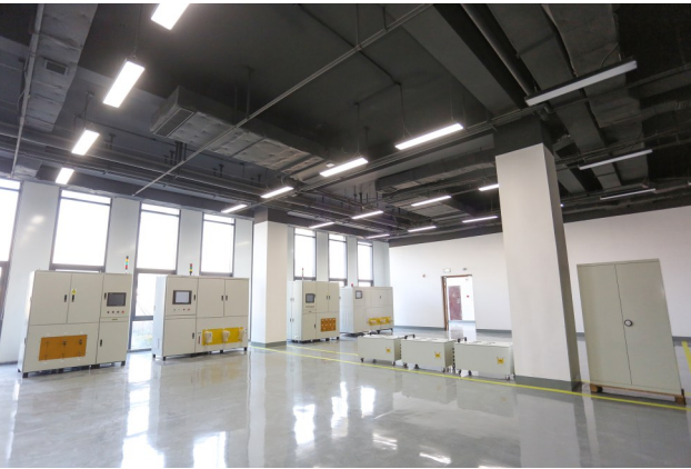
设备进场调试
