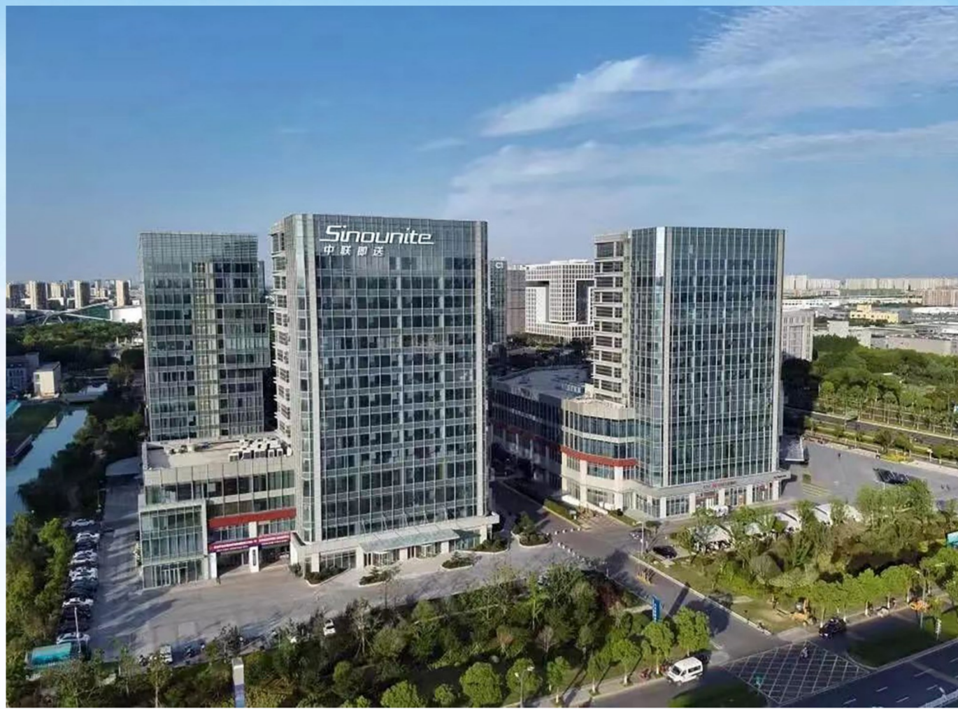
中联即送总部大楼
