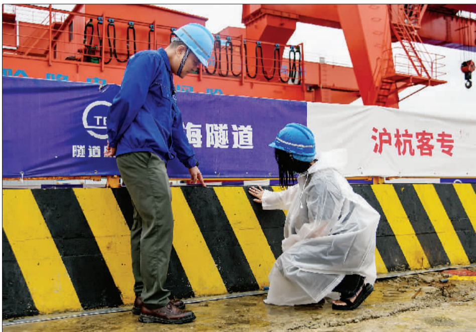
项目部安全总监魏康向记者展示为工作井专门设计的挡水墙和多功能应急防汛箱。
