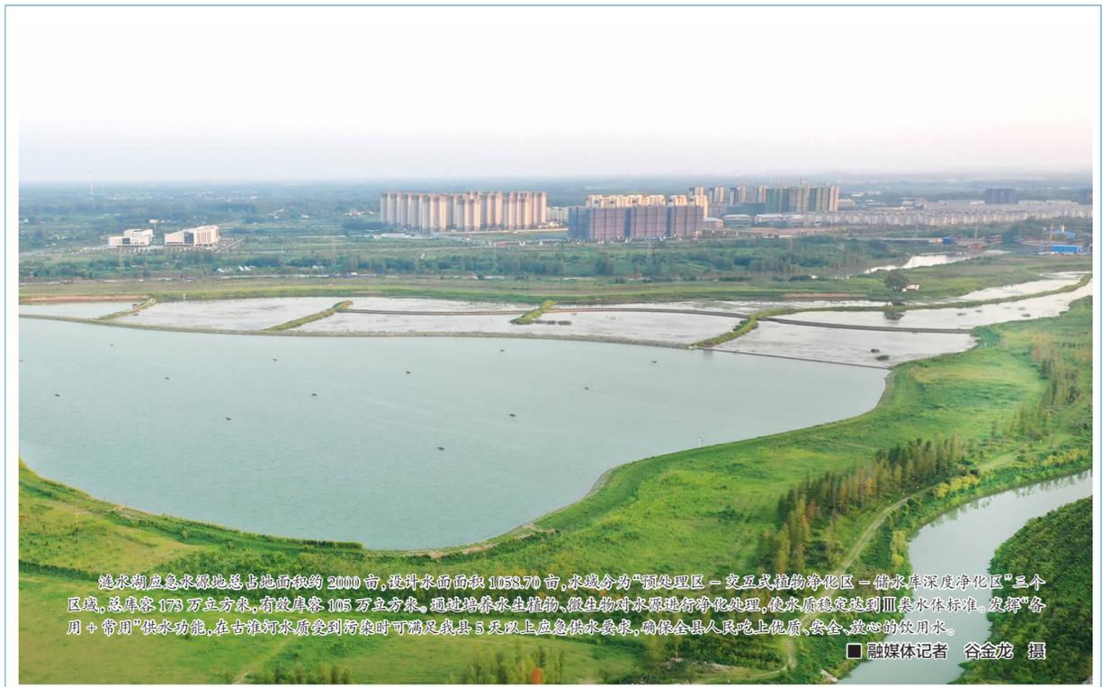
涟水湖应急水源地总占地面积约2000亩，设计水面面积1058.70亩，水塘分为“预处理区—交互式植物净化区—储水库深度净化区”三个区域。总库容173万立方米，有效库容105万立方米。通过培养水生植物、微生物对水源进行净化处理，使水质稳定达到Ⅲ类水体标准。发挥“备用+常用”供水功能，在古淮河水质受到污染时可满足我县5天以上应急供水要求，确保全县人民吃上优质、安全、放心的饮用水。
