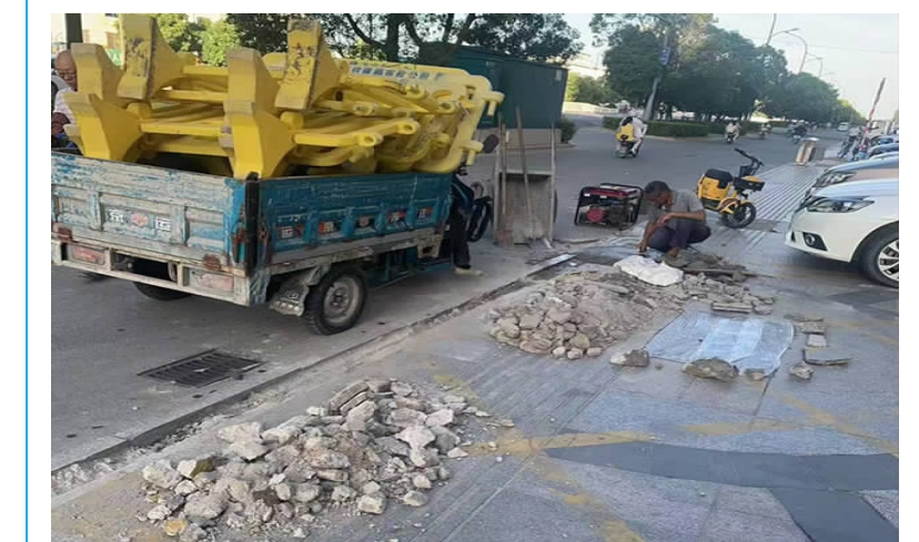
近日,县市政部门加大城区主干道沿线维护工作,对破损路面进行整修,在美化城市环境的同时,又确保人车安全。图为工人正在炎黄大道军民段整修破损路面。
