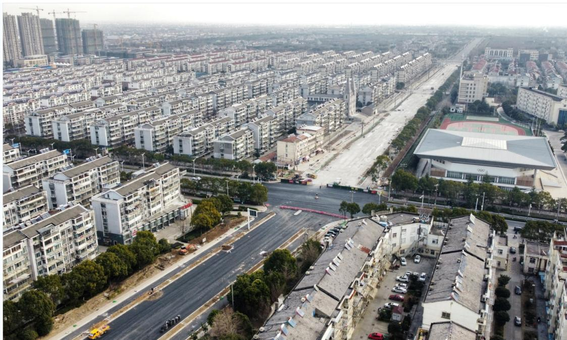
12月28日,紫薇东路改造工程正在加紧建设。该路段东起惠阳路,西至民胜路,全长1000米,改造后将拓宽成双向六车道,中间设隔离带。目前,已完成工程量的80%,预计春节前通车。(融媒体记者 姜新春摄)
