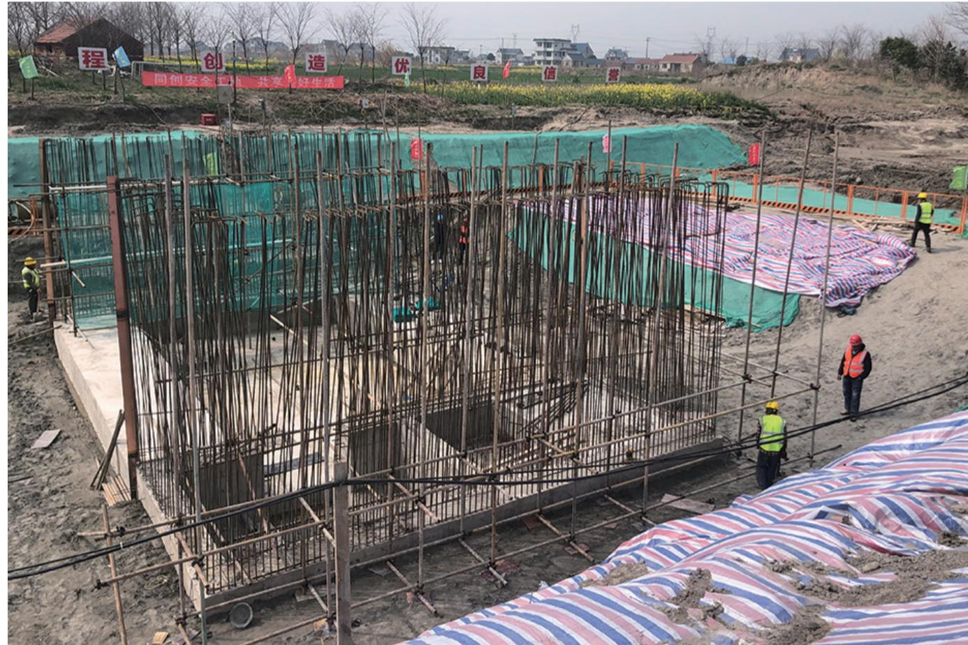
近日,在四貫河钢坝闸施工工地,钢坝闸已完成闸底板浇筑,计划5月底完工。钢坝闸位属我县区域治水的公共河掘坎河片区,该片区治理主要包括新建两座钢坝闸、两座溢流坝及维修1座老旧涵闸,建成后,将营造水势,从如泰运河引水至片区内进行活水畅流,提升片区内部的水环境质量。
