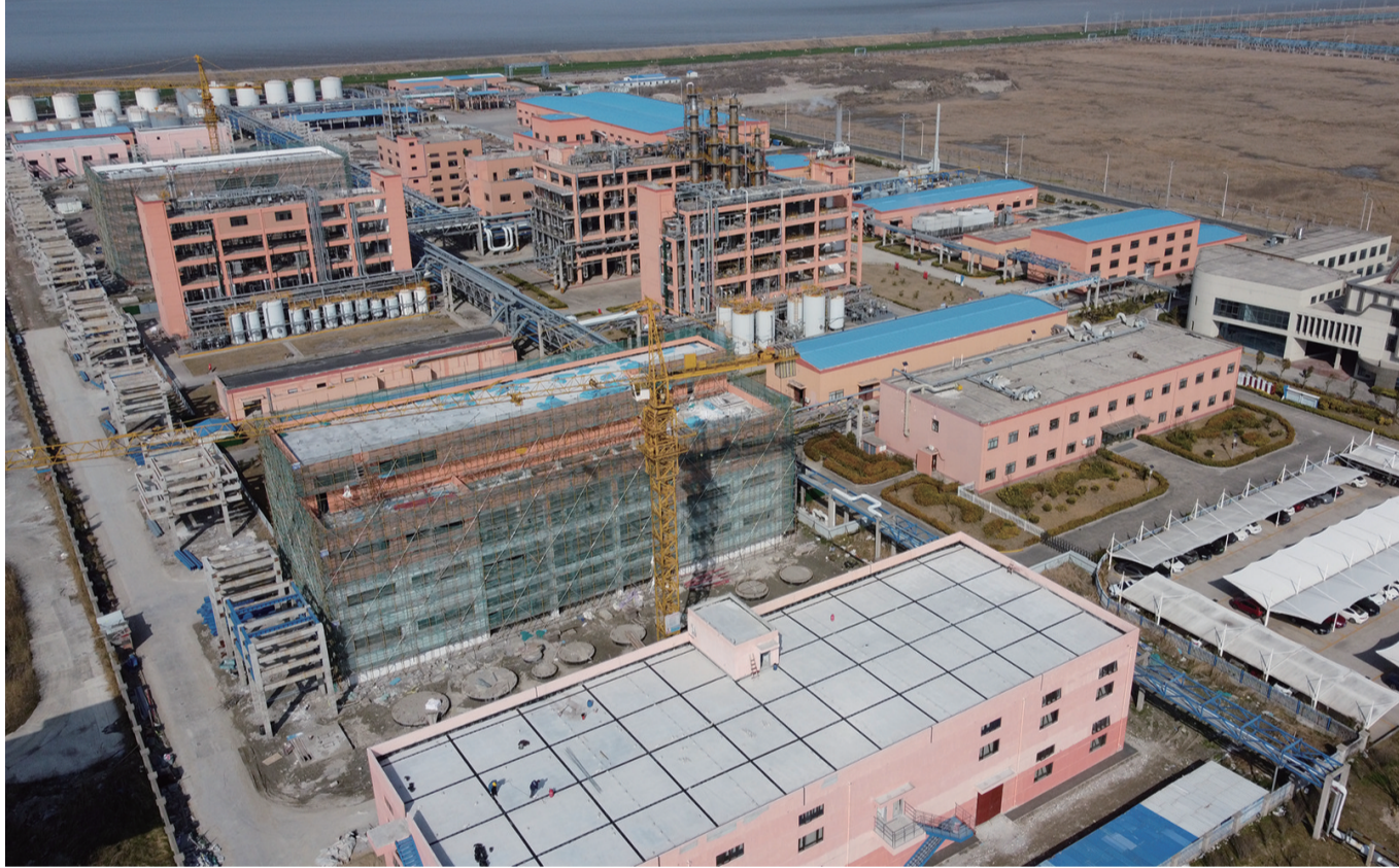
福瑞达扩建项目位于洋口港经济开发区,占地42亩,建筑面积11948平方米,年产聚异丁烯丁二酰亚胺分散剂8.4万吨、横酸盐清洗剂2.6万吨、ZDDP抗磨剂6250吨、复合剂1.2万吨及副产品硫磺243吨。 全媒体记者 王洪通讯员 陈铃 摄
