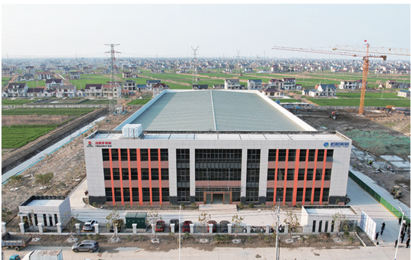
位于大豫镇的诺阳新型家居产业基地及功能性云仓项目总投资超5亿元,占地48亩。经过前期紧张施工,该项目一期工程已经封顶,目前已完成总工程量的60%,项目投产运营后,预计年产各类创新智能家居产品600万件。全媒体记者 单佳凯 摄
