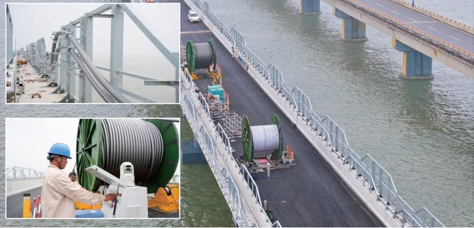
方米,本期将安装50兆伏安主变两台,新建110千伏出线4回、10千伏线路24回、110千伏电缆通道16.56公里、架空线路5.2公里。其中,关键电缆工程采用随桥敷设方式,借助黄海二桥两侧预留的电缆沟布置16.56公里长的电缆,建成后,能够为岛内已投运及在建的4座LNG接收站提供稳定的电力保障,破解阳光岛用电瓶颈问题。
