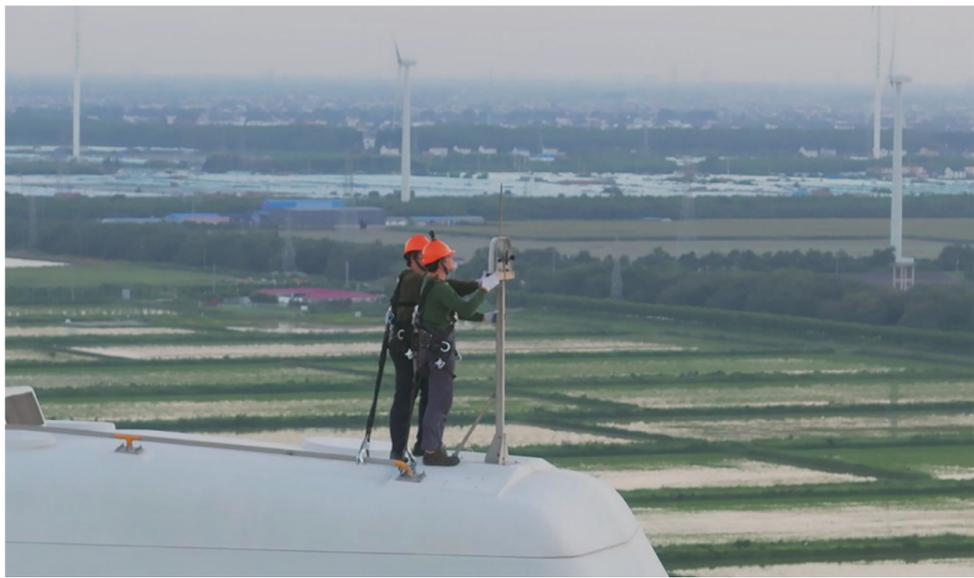
连日来,针对高温天气,江苏龙源如东环港风电场组织工程师,对风电机组开展专项维护保养工作,通过添加润滑油、更换碳刷、检查风向标等方式,确保机组稳定运行。据悉,2006年如东环港风电#21号风机首次并网发电,改写了江苏作为经济大省、风资源大省没有风电的历史。近年来,该公司守正创新,深化改革,勇担使命,奋力建设一流标杆新能源企业,不断谱写高质量发展之歌,为地区经济又好又快发展做出突出贡献。截至目前,环港风电场共建有风电机组105台,年发电量2.8-3亿千瓦时,有效保障民生需求,护航经济发展。
