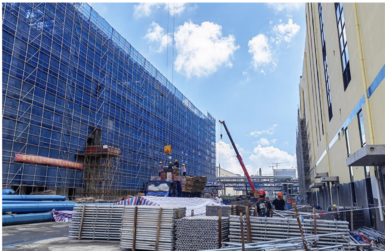
图为常佑药业项目建设现场。
