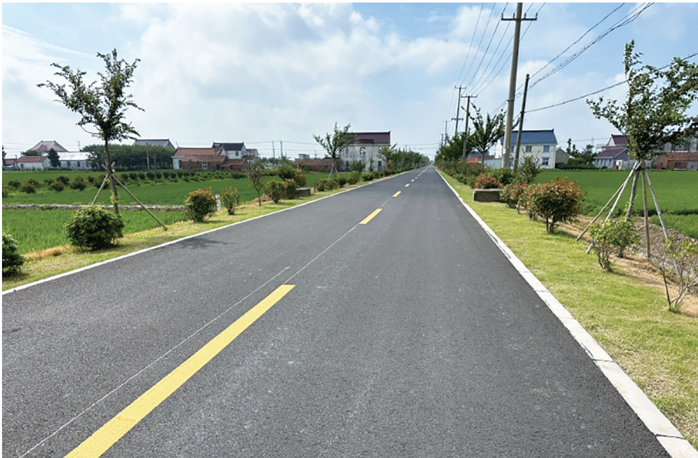
乡道丁七线位于城中街道，路线总体呈南北走向，北起川杨线，向南延伸至於花桥，全长约6.9公里。此次施工对老路进行病害修补后统一加铺一层沥青，对现状暗渠进行修复，绿化进行整治，投资约540万元。
