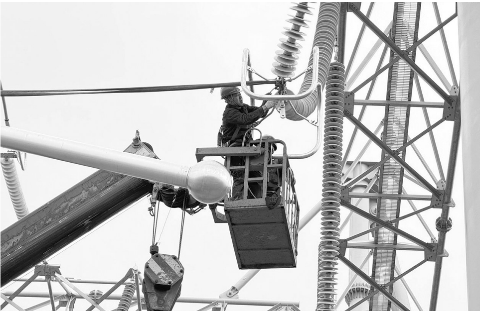
邛崃500千伏变电站内施工人员正在安装管母线（国网四川电力供图）
